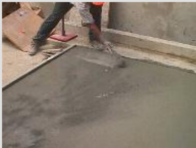
Se procede a la colocación del toppingcolor
