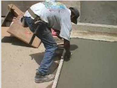
Se procede a la delineación de las juntas con el "raton"
