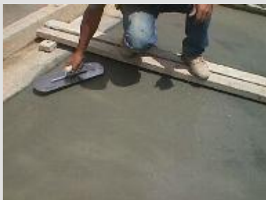
Se procede a la colocación del toppingcolor
