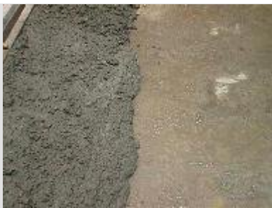
Vaciado del concreto, F ´ C = 200 Kg/cm 2 , Asentamiento 4", con fibra de polipropileno
