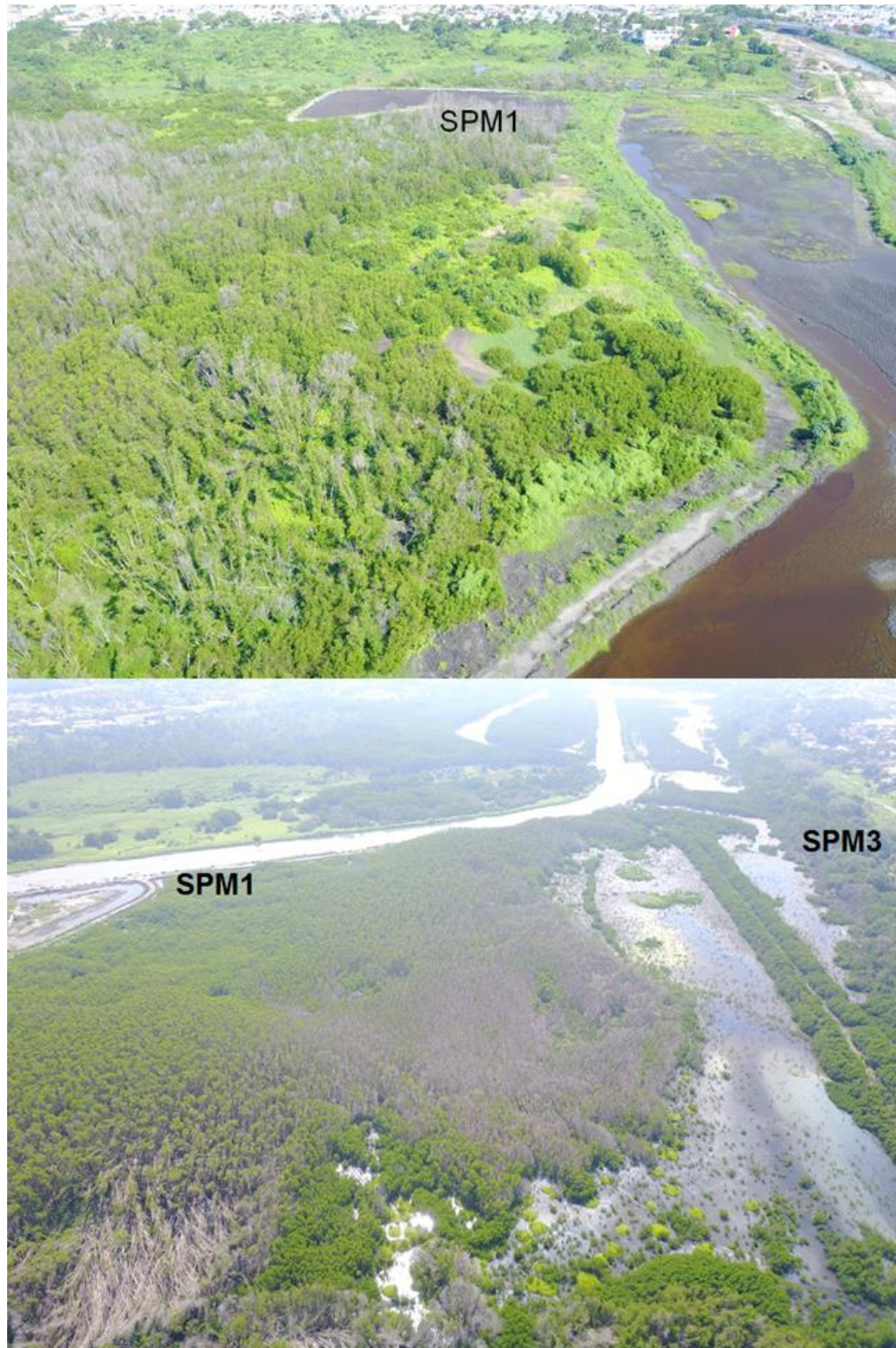
Figura 54. Suministro y distribución del agua en los SPM1 y SPM2. Fotografías tomadas con dron mavic 2 el día 21 de octubre de 2021.
