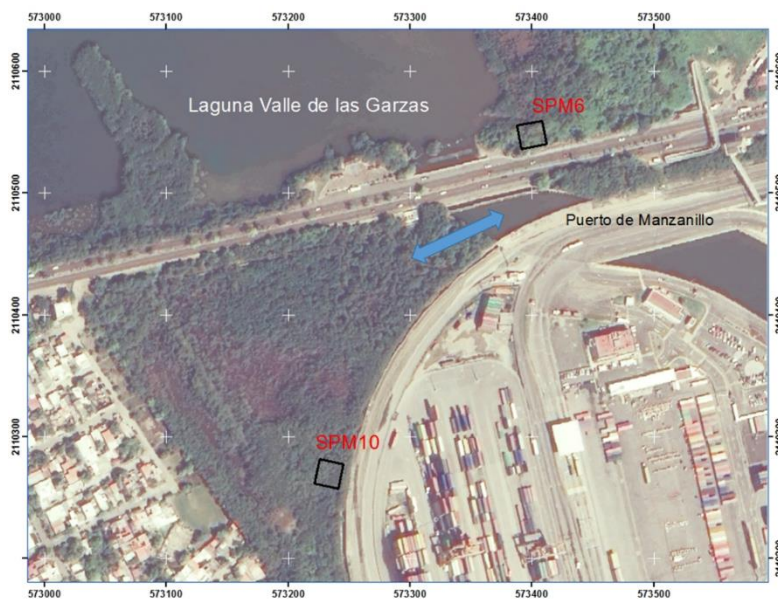
Figura 35. Canal de agua que comunica el Puerto Interior y la Laguna Valle de las Garzas, suministra agua el SPM10. Imagen de satélite Pléiades de octubre de 2021.
