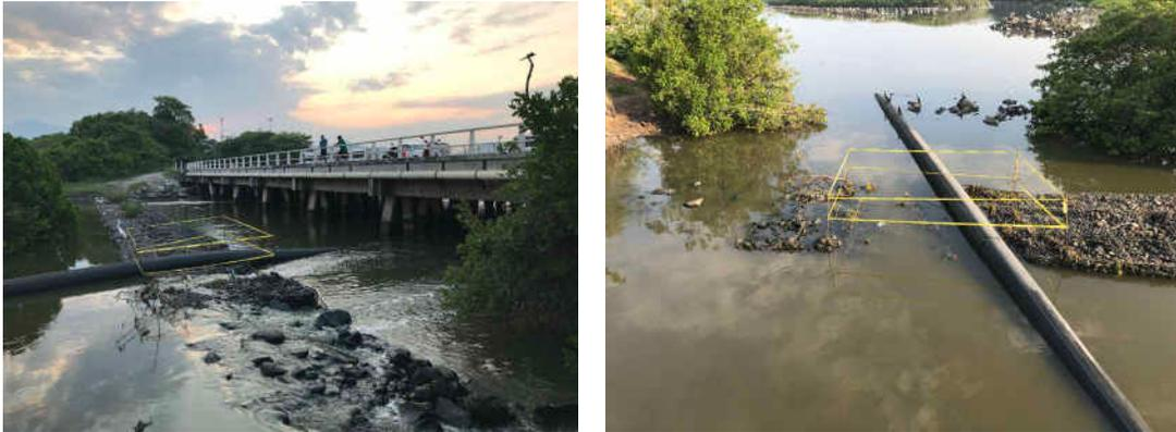
**Figura 14. Instalación del tubo de la draga en la laguna del Valle de las Garzas.**
