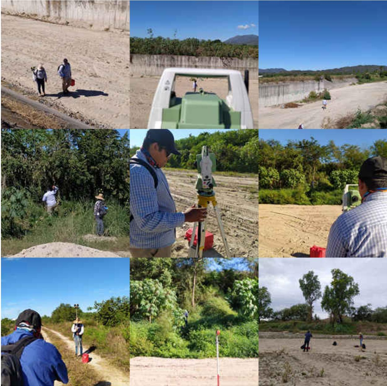
**Figura 78. Mediciones topográficas en el cauce principal de la cuenca en estudio 1.**
