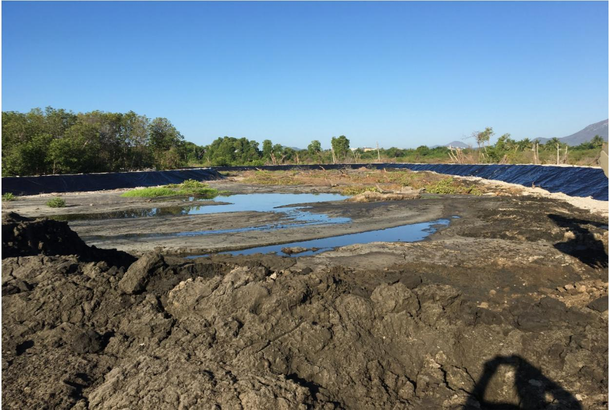
**Figura 42 Vaso de depósito de material dragado en construcción.**
